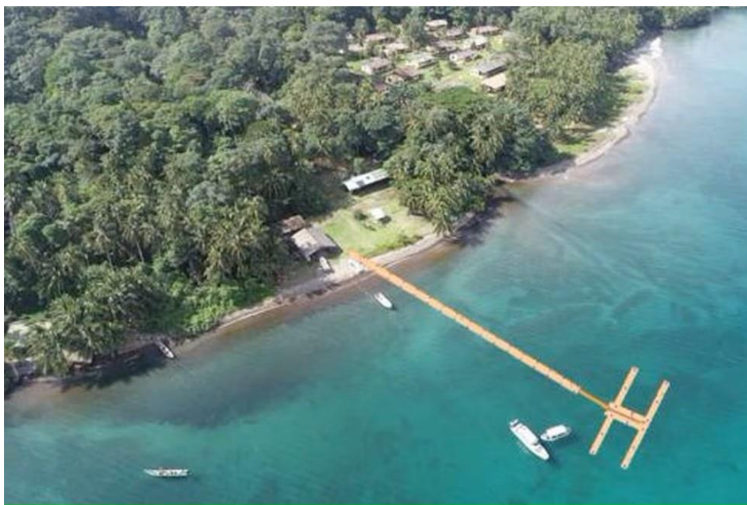
Imagen difundida por el Ministerio del Ambiente y Desarrollo Sostenible sobre la propuesta ampliación de una estación de guardacostas.
